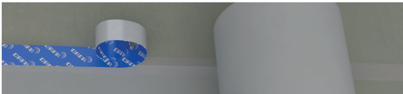
Dampspærrefolien monteres med overlegg og tapes med DAFA dampspærretape.
