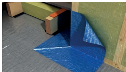
DAFA Außenecke am Boden
