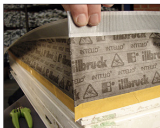
Folien monteres til karmen inden vinduet monteres. Alle hjørner udføres med en fold på 1-2 cm, for at folien kan nå ud til hjørnet af lysningen.
