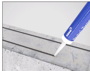
Der udlægges 2 striber butylfuge inden folien udrulles
