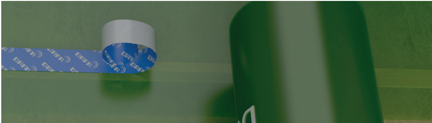
Dampspærrefolien monteres med overlæg og tapes med DAFA dampspærretape.
