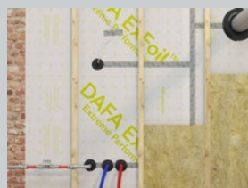
For rør og kabler. Montert på dampsperre.
