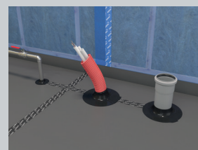
Montert på radonsperre.
