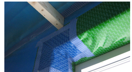
Utvändigt DAFA-hörn vid fogning
