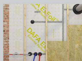
Til rør og kabler. Monteret på undertag
