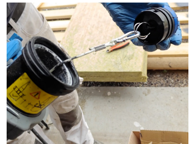
Bundproppen sidder fast med en wire eller kæde, og skal isættes igen, inden ny pose sættes i røret.
