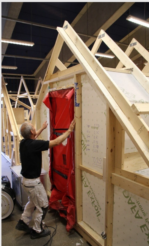
DAFA ExFoil prøvemontage på Roskilde Tekniske Skole
