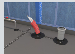
Monteret på radonspærre
