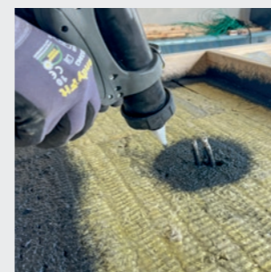
DAFA SprayBarrier™ DAFA SprayBarrier er specielt udviklet til at tætte i områder hvor det er udfordrende at tætte med traditionelle dampspærre og fugemasser. Ved at være både spraybar og penselbar kan komplekse små samlinger tættes. Læs mere på www.dafa-build.com/dk/spraybarrier
