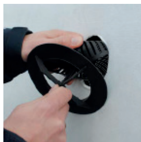
Klem den nedre ventilen slik at den nedre er plassert mellom dekselet og den nedre delen.
