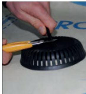
Stripen er kuttet med ca. 1 cm over dekselet.
