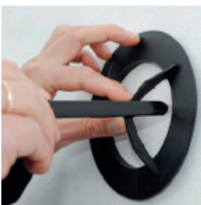
Merk og kutt hull i taket.
