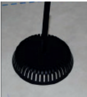
Den nedre ventilen er nå montert.
