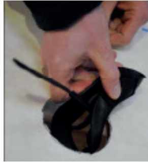
Trykk den nedre delen sammen og før den inn på baksiden av taket.
